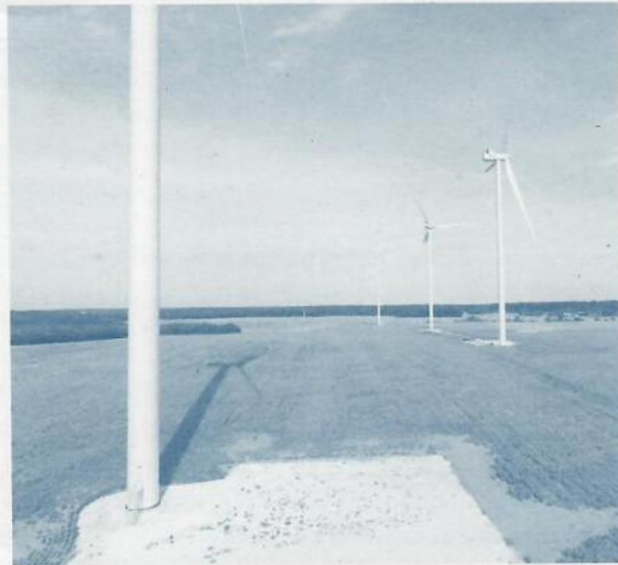
Parc éolien de Vouillon, août 2019 (photo A. Boyé)
